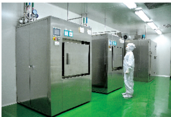
容生冻干粉针剂车间
